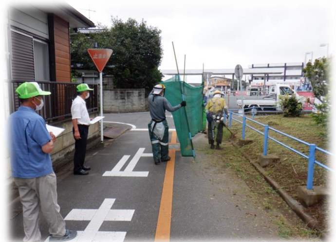
△清掃作業箇所の状況確認中
